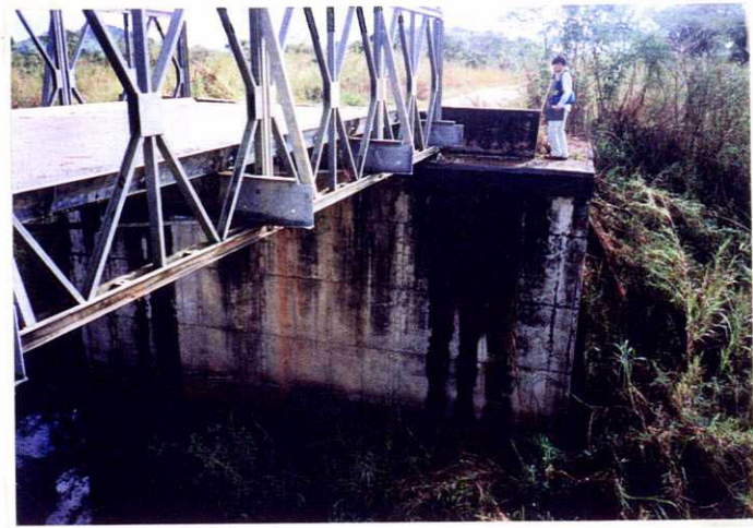
写真-14 サンバレンド橋 (国道225号線)
