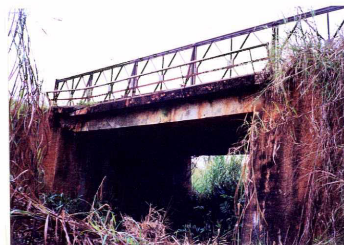
写真-8 マラタ橋 (国道104号線)
