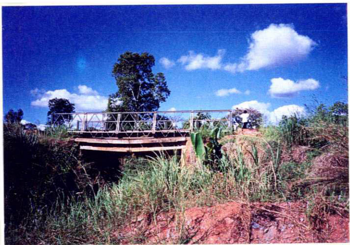
写真-7 ナミラテ橋 (国道104号線)
