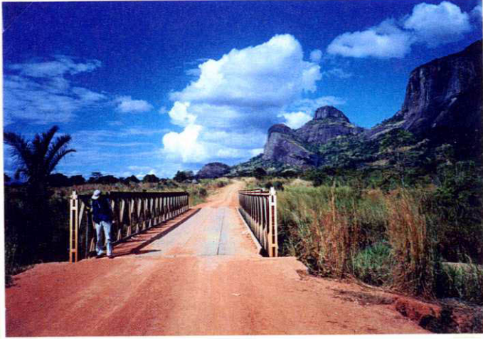
写真-1 ナテテ橋 (国道8号線)
