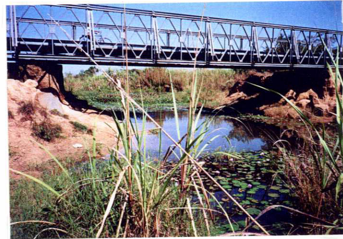
写真-10 ムニヨニャ橋 (国道225号線)
