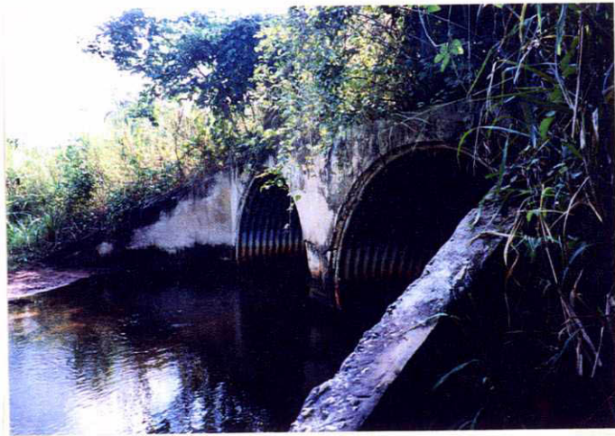
写真-9 ビリラ橋 (国道225号線)
