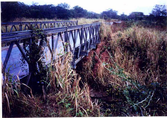
写真-13 ナミフンゴ橋 (国道225号線)
