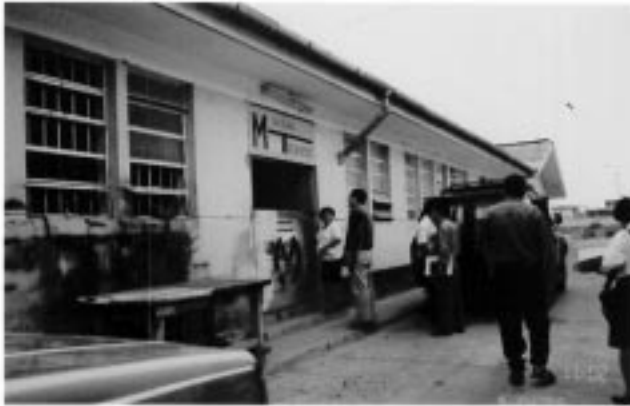
写真13：トクベス県700-ジ・トクベス病院敷地内にあるトクベス県中央倉庫
