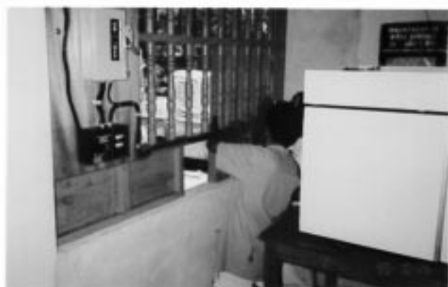
写真35：ソーラー式冷蔵庫の設置配線
