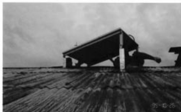
写真38：ソーラー式冷蔵庫ソーラーパネルの設置
