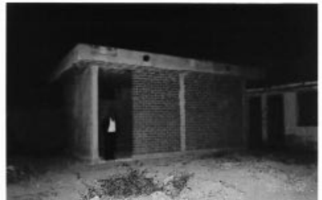
写真30：同県 中央倉庫 新しく建設中のワクチン保管用倉庫
