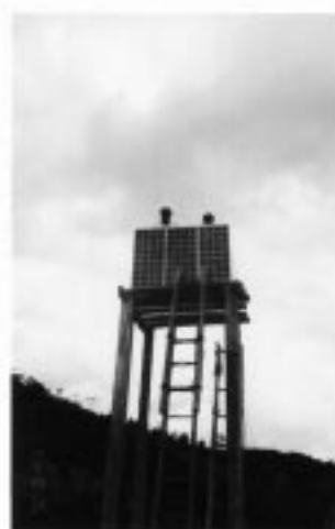
写真40：ソーラー式冷蔵庫ソーラーパネルの設置
