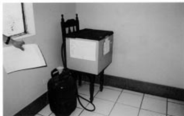
写真23 : 同診療所の冷蔵保管用ガス式冷蔵庫
