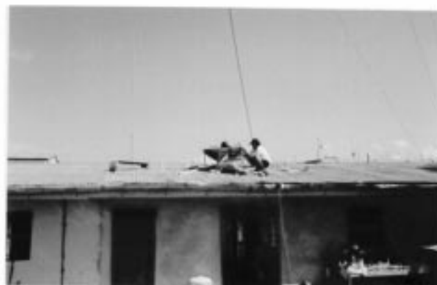
写真34：ソーラー式冷蔵庫ソーラーパネルの設置
