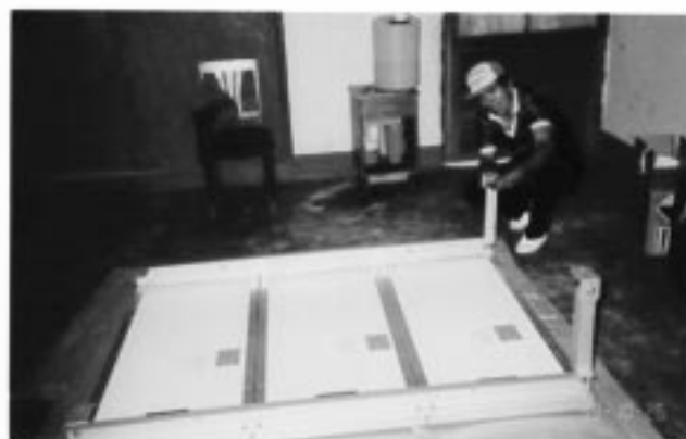
写真36：ソーラー式冷蔵庫ソーラーパネルの組立て
