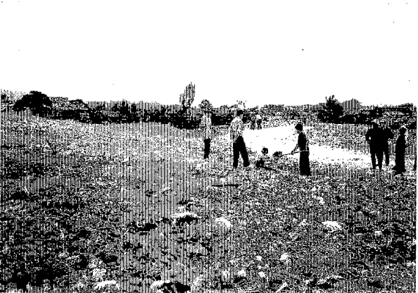
Kien An区埋立地埋立風景(Trang Than)
