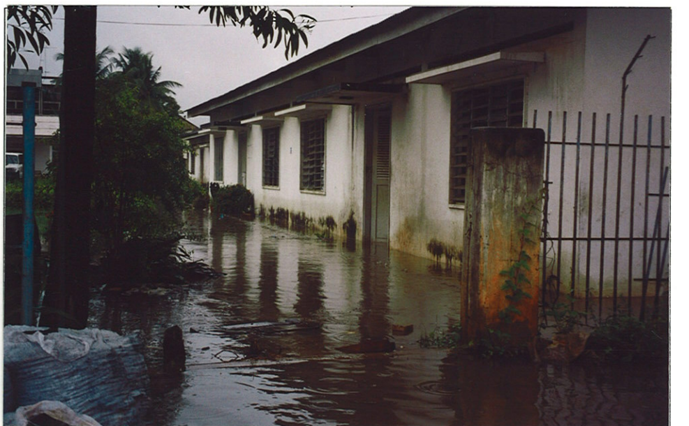
8. 敷地東側の前面道路から見た、洪水時における CENAT の病棟ゾーンの状況。ここでも道路および敷地内が一樣に冠水し、さらに病棟内部にも浸水している。
