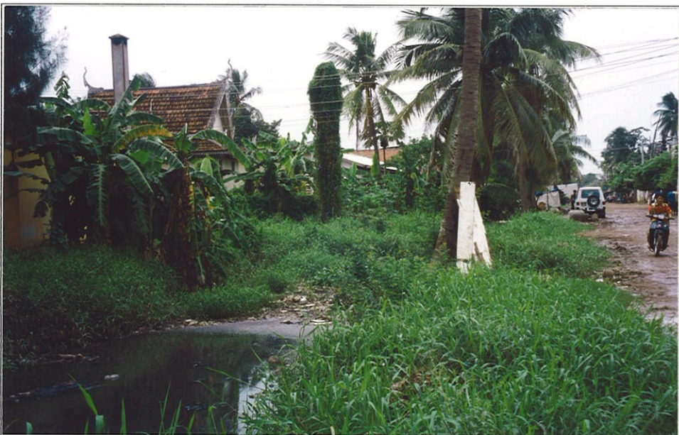
5. 敷地北西角より運河を見る。堆積した廃棄物により流れが滞っている。ADB融資による運河改修計画は2000年1月より下流から開始され、2002年7月頃に上流の CENAT 敷地横まで達し、完了する予定である。
