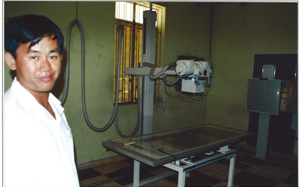
4. 検査棟1階のX線撮影室内にあるX線機材。1993年の無償案件による供与機材で現在も稼働しており、本件の機材計画にあたっては、こうした稼働中の既存機材との併用について十分な検討を行った。
