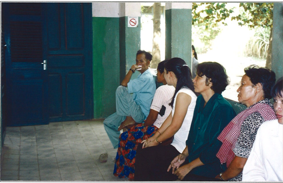
1. 管理棟1階の外来で受付を待つ患者の様子。元々外来用に作られていないため、待合いスペースはなく廊下を使用する等、建物の現状が要求される機能を満たしていない。
