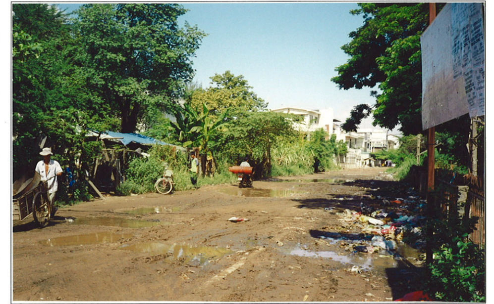
4. 敷地北側道路 (Road278)。未舗装で排水溝も未整備なため、降雨時は通行困難となる。敷地の向かい側は高校で、工事期間中は生徒の安全性に配慮する必要がある。
