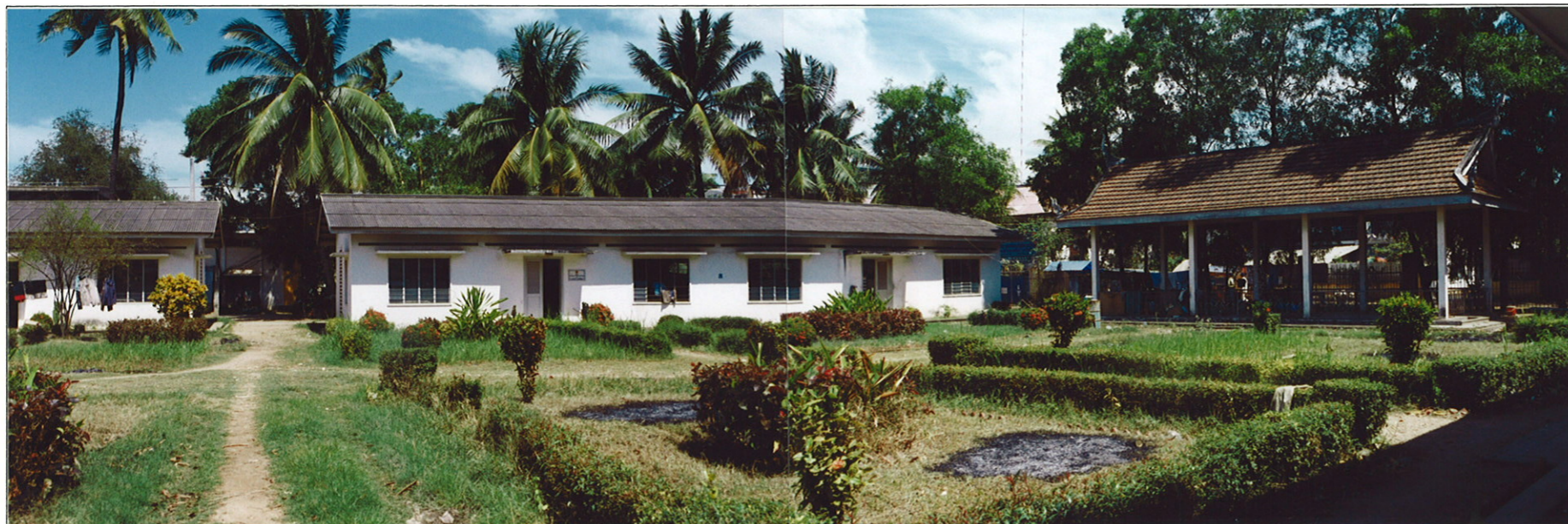
3. 敷地南側は、結核病棟が中庭を囲む。病棟内には所狭しとベッドが並べられており、ベッド占有率は高くない(70~100床/150床)が、患者のプライバシーが守られる状態ではない。中庭は比較的整備されているが、患者とその家族は病棟周辺で自炊することもあり、病棟周辺にはゴミが多く不衛生な状況にある。
