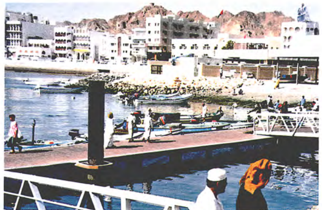
魚市場ホールの前面の浮き棧橋 殆どの水揚げ漁船は5~6m程度の FRP船外機ボートである
