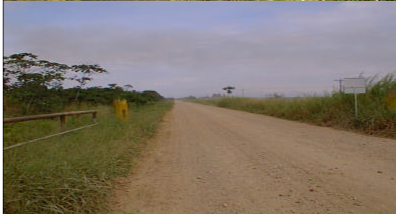
Condición actual del camino (km. 36): ancho 8 a 10m.
