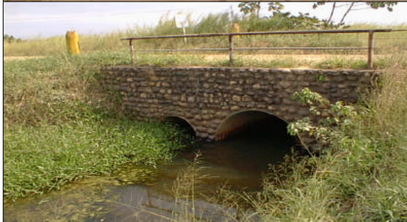
Estructura en km. 36:
