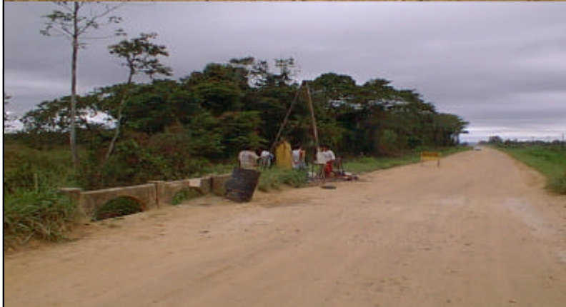
Punto de perforación, condición de maquinarias (Puente Tejerías)
