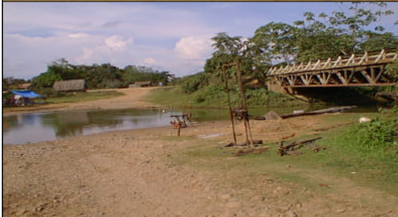
Punto de perforación, condición de maquinarias (Puente Yapacanicito)
