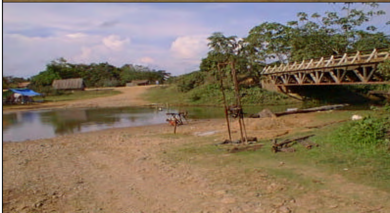
ボーリング位置、機械状況 (ヤバカニシート橋)
