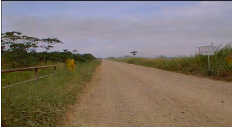
現況道路 (km36付近): 幅員8 ~ 10m
