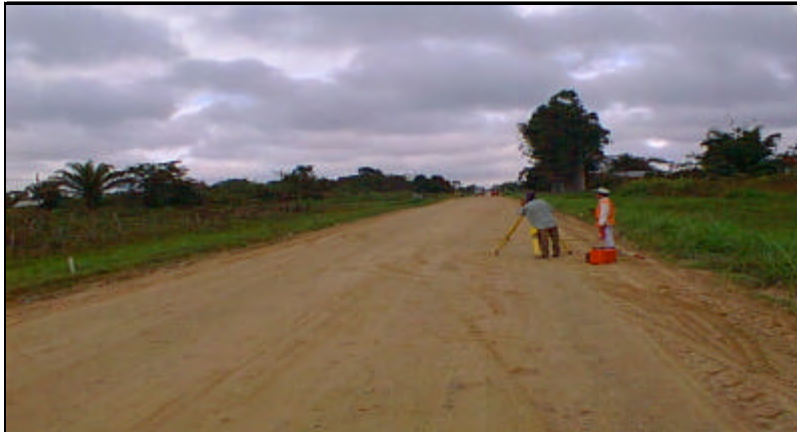
中心線、縦・横断測量状況
