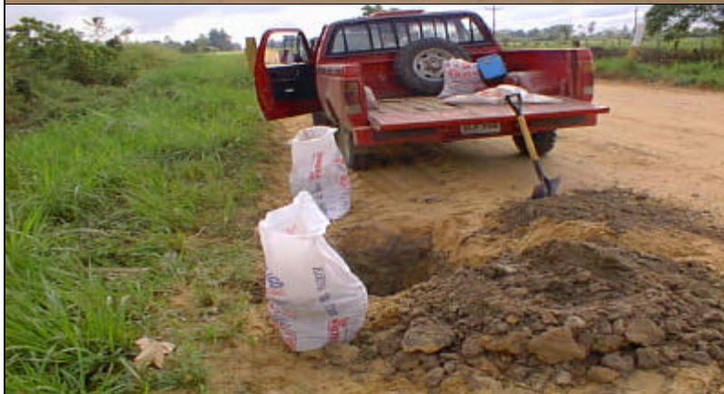
CBR試料採取状況 (km9付近)
