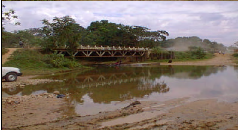
ヤバカニシート橋 (km48付近): 橋長24.5m幅員3.8mの木製の上 路トラス橋 (下流より)
