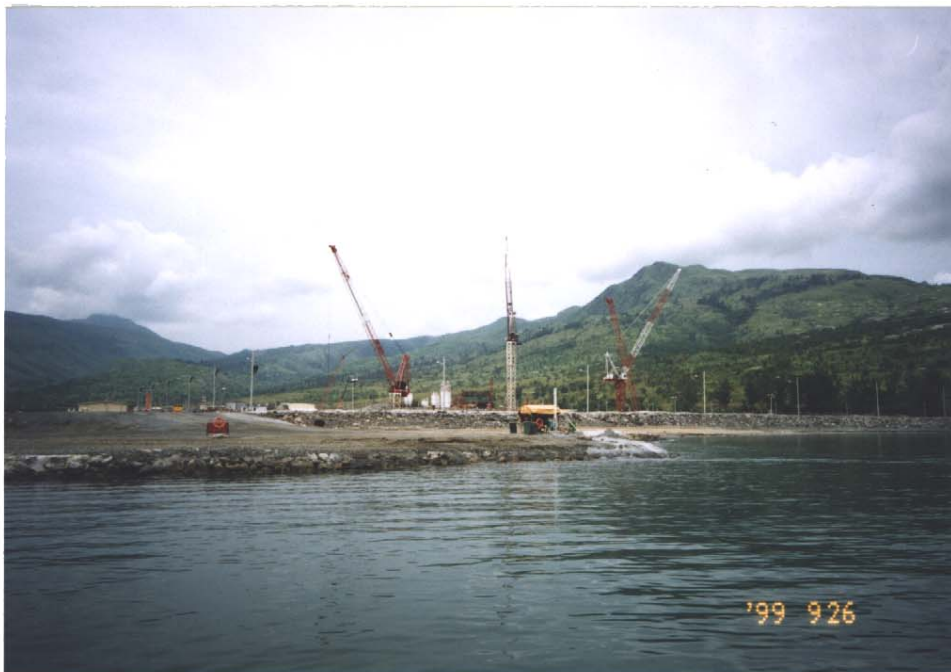
CGS (Concrete Gravity Structure) 建設現場
