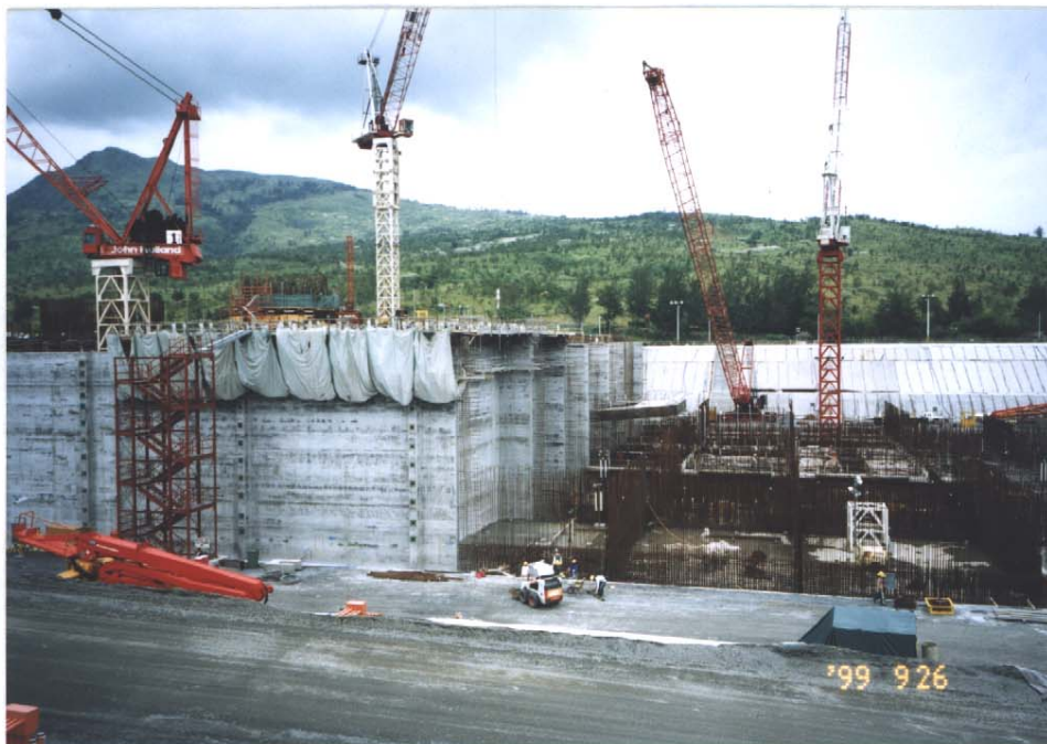
ドック内で建設中の CGS (Concrete Gravity Structure)
