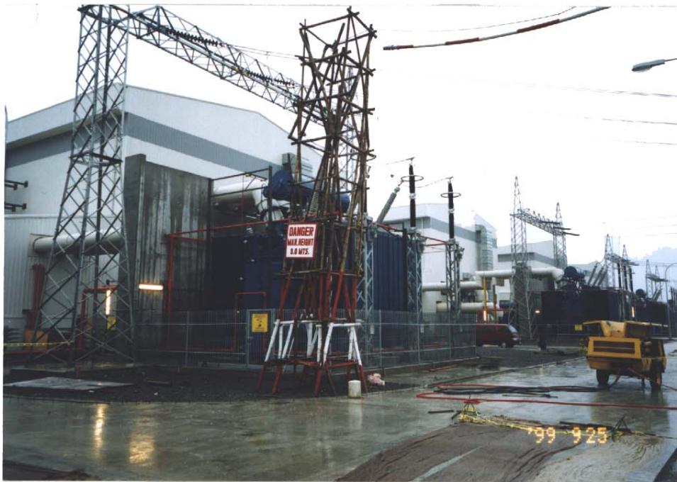
建設中の Sta. Rita 発電所 (250MW×4)
