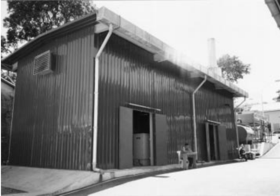
シアヌークヴィル発電所建屋（新発電設備）
