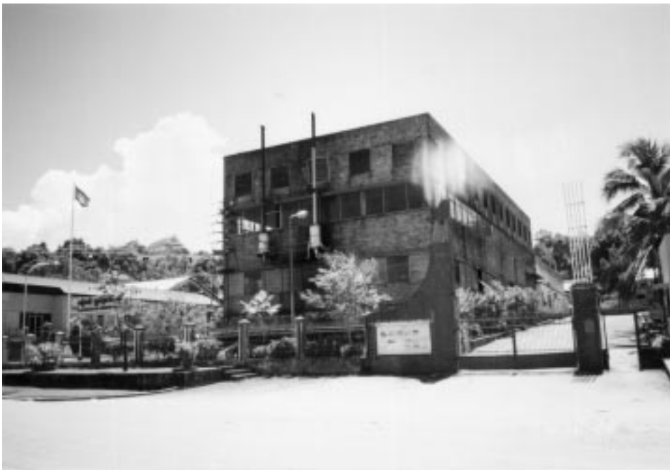
シアヌークヴィル発電所建屋（旧発電設備）
