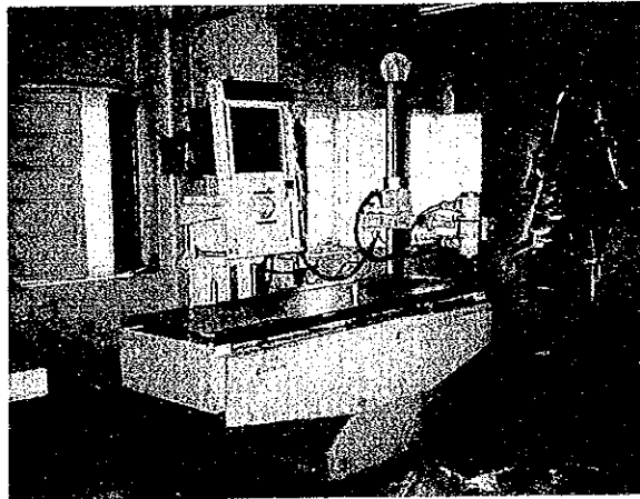
X線室：室は放射線防護されていない
