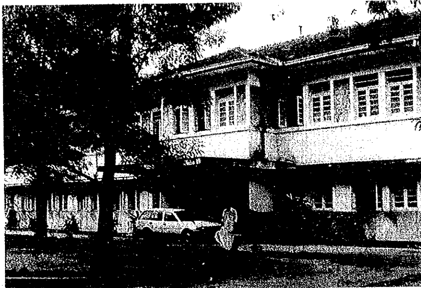
外観：病院東側ロータリーより既存病院の改修部分をのぞむ
