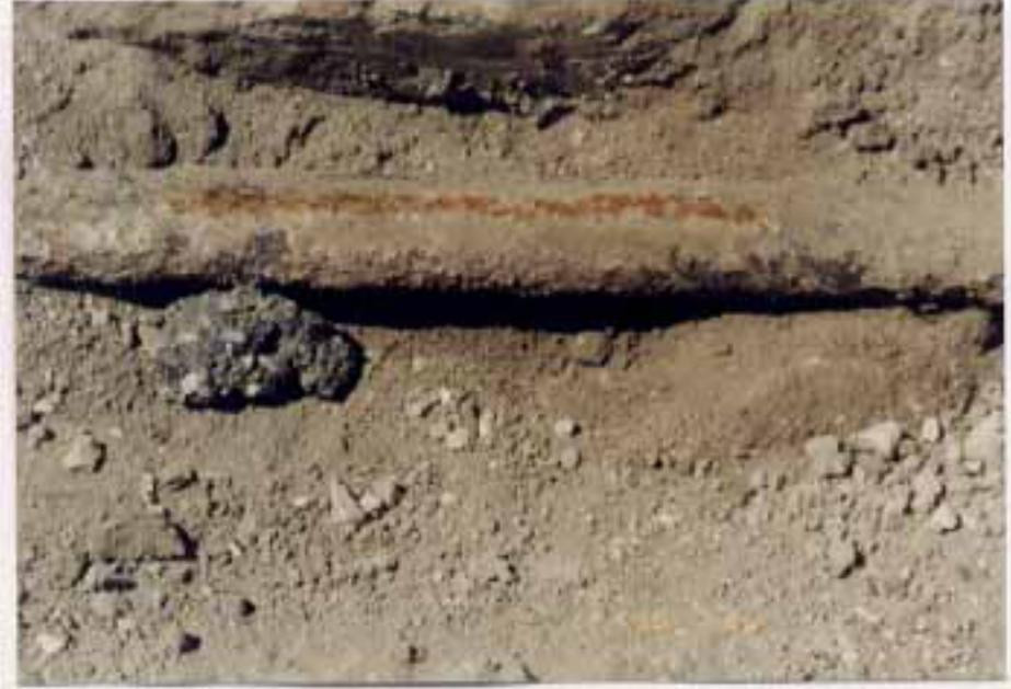
同じく 50mm 配水管の試掘調査。配水管の周辺の土は湿っており、管からの漏水が原因と思われる。
