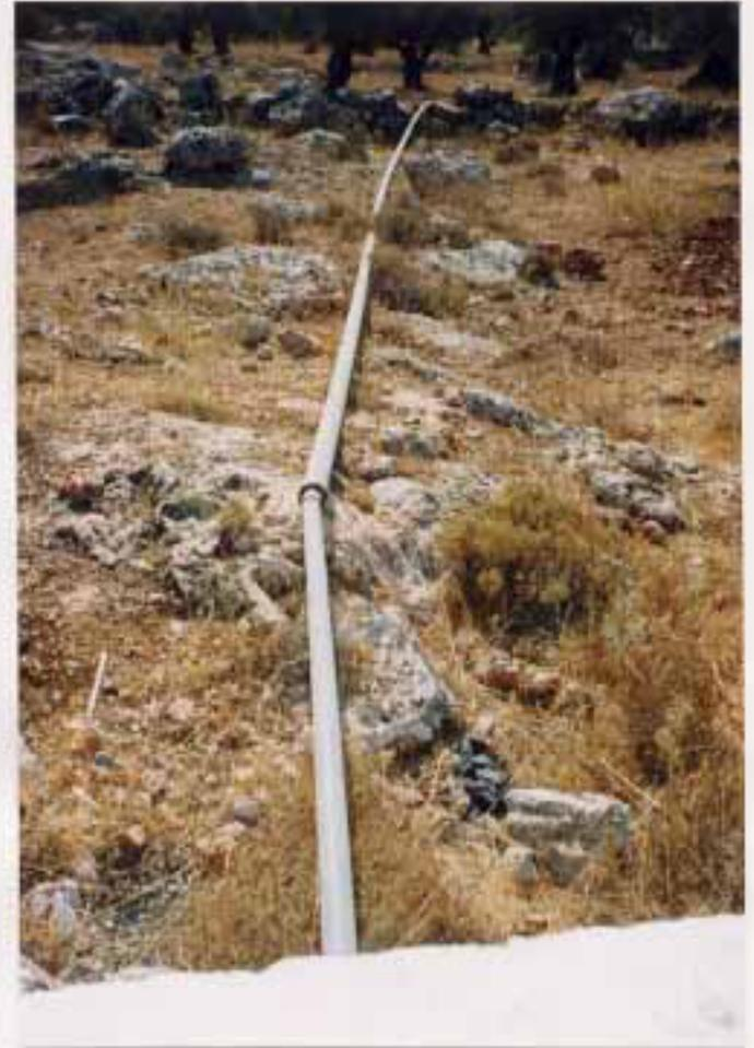
Mekorot 送水幹線との接続点からの 50mm 配水管は、地上配管となっている。
