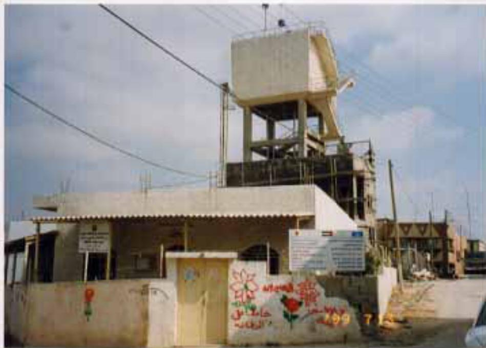
既存の高架型配水池(容量 200m<sup>3</sup>, UNDP 援助による)。本計画では右の水源井戸から同配水池までの送水管布設及び配水池から給水区域への配水管網整備が対象である。
