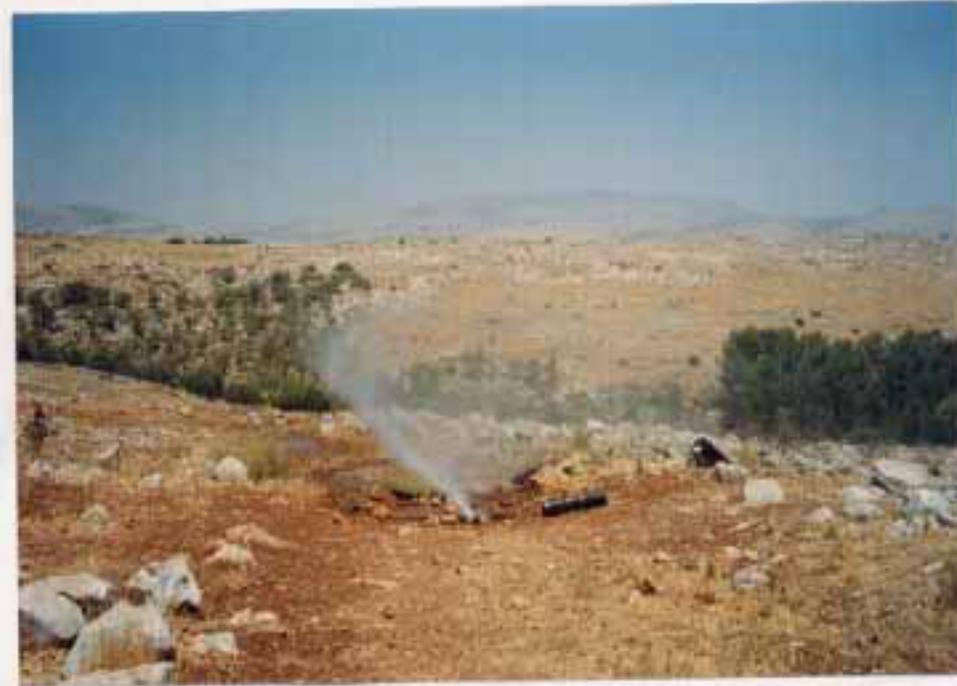
既存送水管の状況。漏水が激しい。修理が頻繁に行われている。
