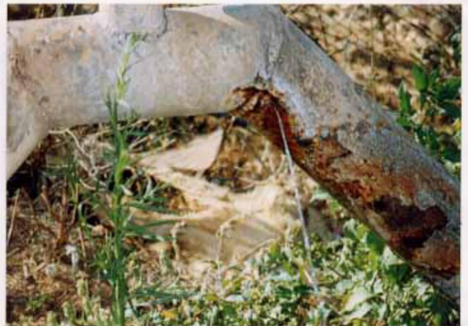
既存配水池からの配水管。部分的に錆びて漏水している。
