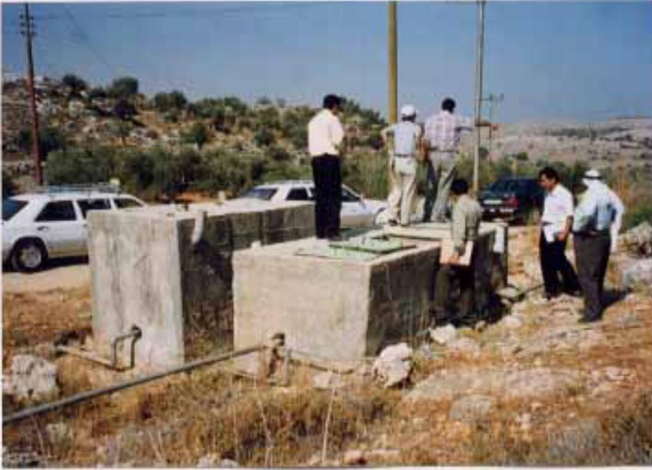
Mekorot 送水幹線との接続点。50mm 配水管で市街地に配水しているが、管径が小さいため給水量及び給水圧不足となっている。
