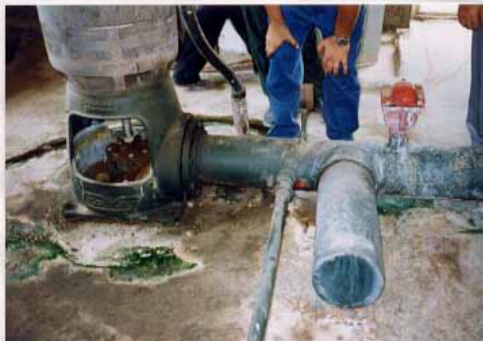
本計画送水管(口径 250mm)が接続される取合い点の状況。
