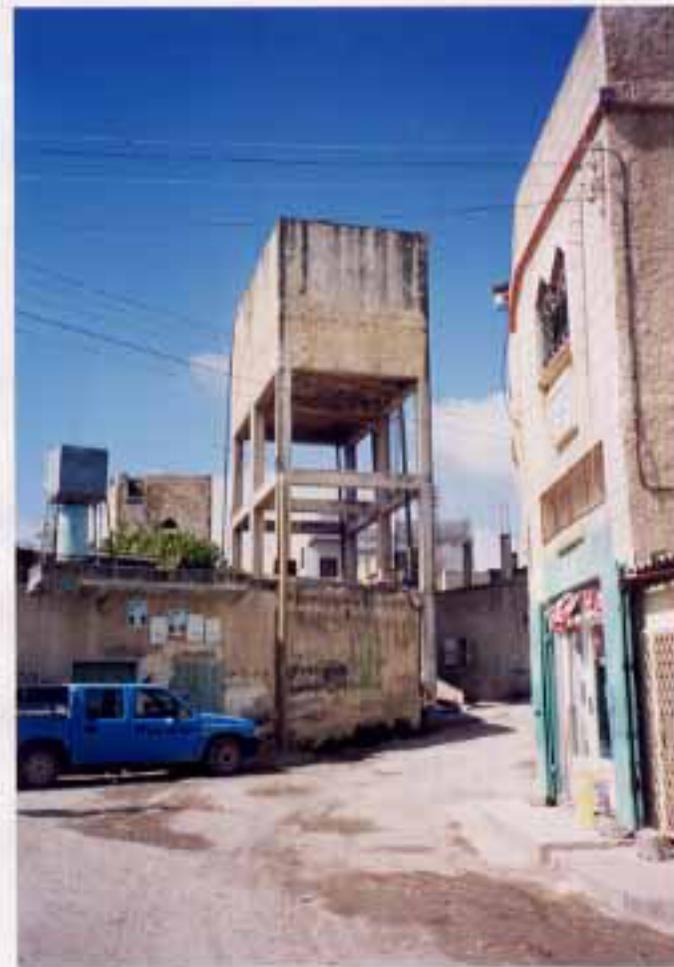
既存の高架型配水池(容量 300m<sup>3</sup>)。Mekorot 送水幹線から同配水池まで送水管布設及び同配水池から給水区域までの配水管網整備が本計画の対象。
