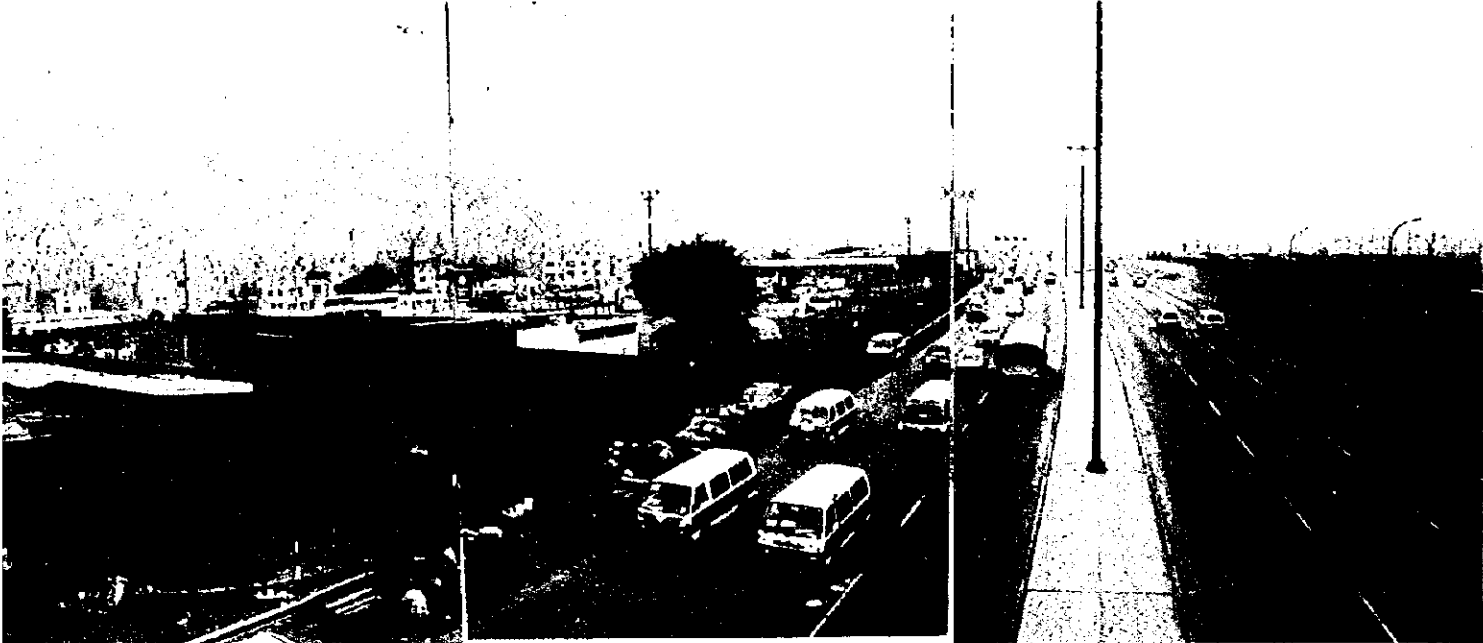
Av. Evitamiento (パンナム有料高速道路)
