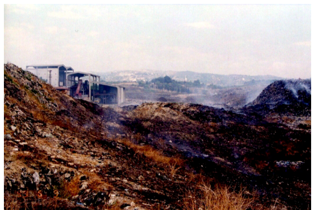
コンポスト工場最終処分場におけるオペレーションの現況。
