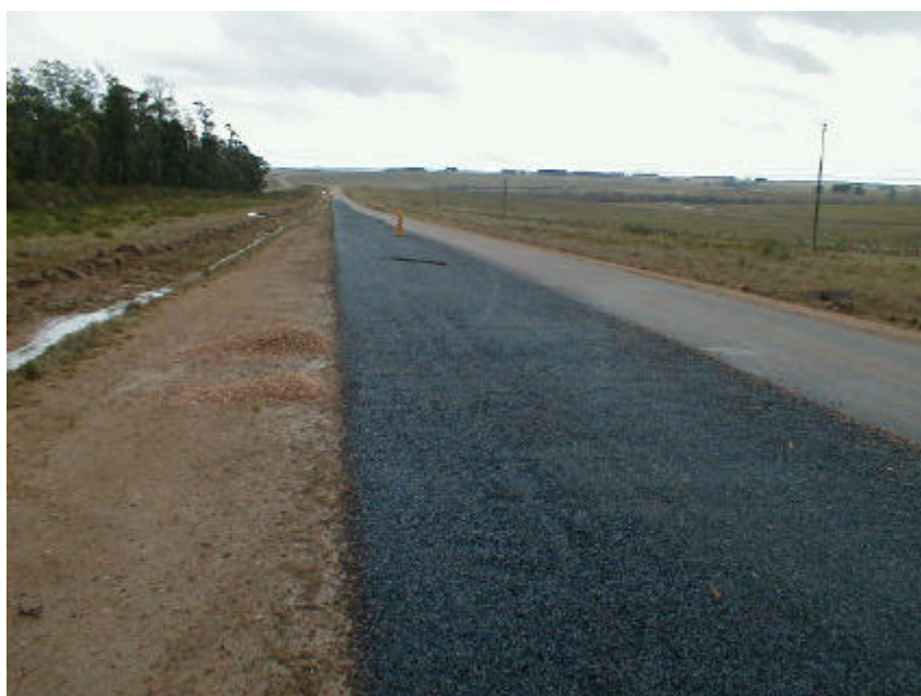
図 1.5-16 14 号線のアスファルト舗装と拡幅改修状況
