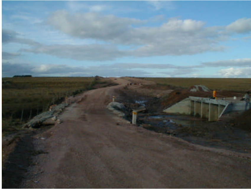
図 1.5-17 橋梁の改修状況
