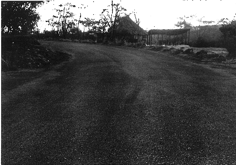
▲簡易舗装道路
