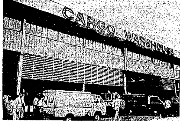
ハリム国際空港航空貨物倉庫
