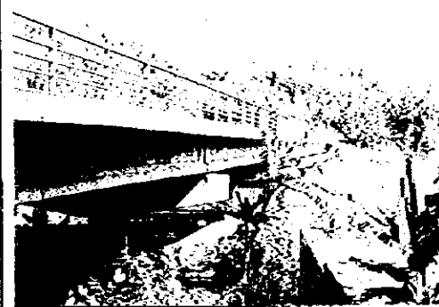
県道200号線モマンス川に架かる橋梁
