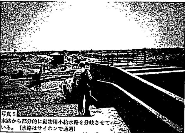
写真5 水路から部分的に動物用小給水路を分岐させている。(水路はサイホンで通過)
