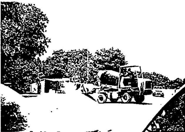
(17) マニサ地区にてアフリカ開発銀行の援助で建設中の道路側溝現場
