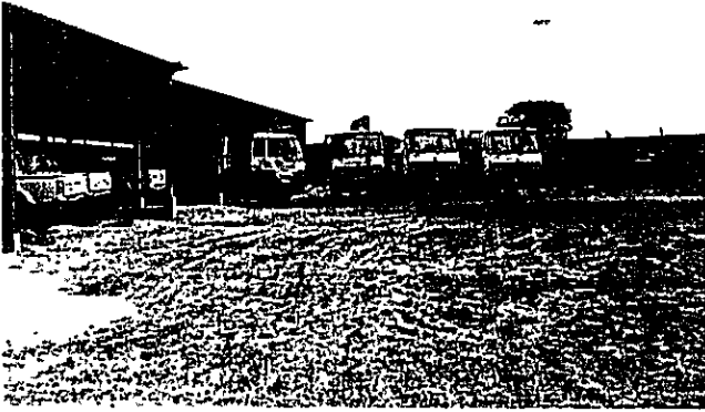
写真-7 カブエのワークショップの様子 日本の協力で建設された。井戸掘削機3台と 約40台の車輛が配置されている。
