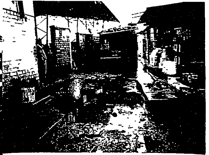
降雨後の状況
