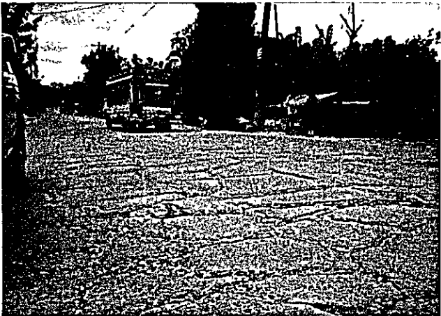
写真9 国道200号線の郊外区間 亀甲状になったコンクリート舗装路面
