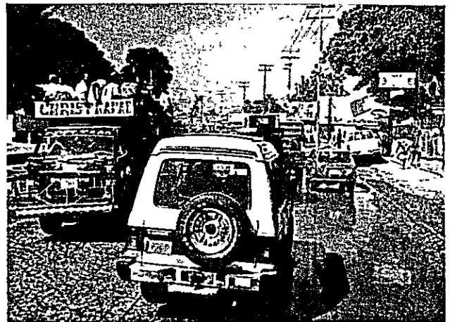
写真8 国道100号線の市内区間 路肩排水の不備により冠水し舗装の破損を 進行させている
