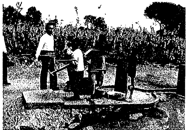
写真-6 子供でも水が汲めるハンドポンプ付井戸 この集落には水管理委員会が設置されている。
