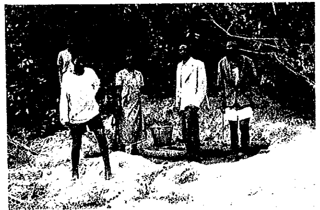
写真-4 Ephangweni の手掘りの井戸 井戸深度が3.30mであるが、水は5cmしか 溜っていない。 水量・水質的に問題が多い井戸である。
