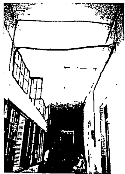
写真-35 廊下部天井照明 夜間の照度不足が容易に想像できる
