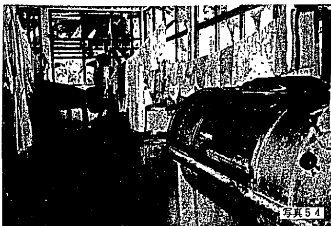
⑦ジョスティニアン病院 ランドリー部門 (稼働不可の洗濯機、脱水器、プレス機)
