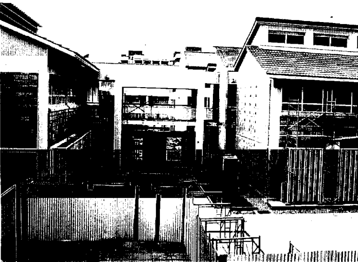
(A) 校舎棟右側廊下2階から 撮影
