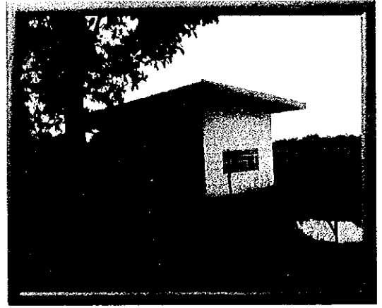
周辺地区の既存ポンプ施設(サイト 9)
