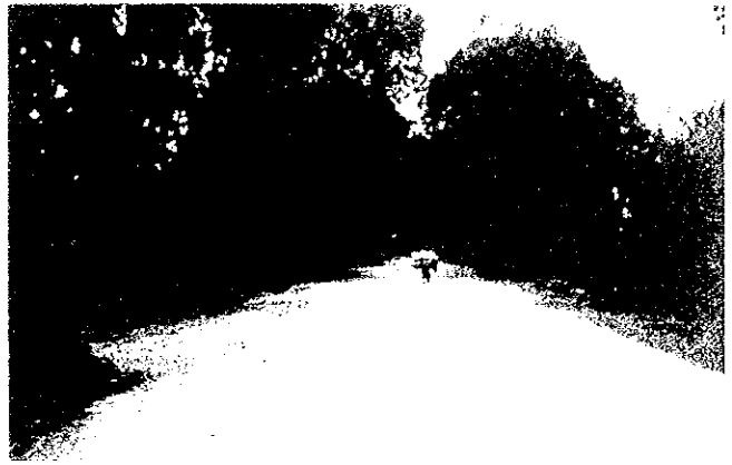
KM301+400 (地方部バライ区間)
