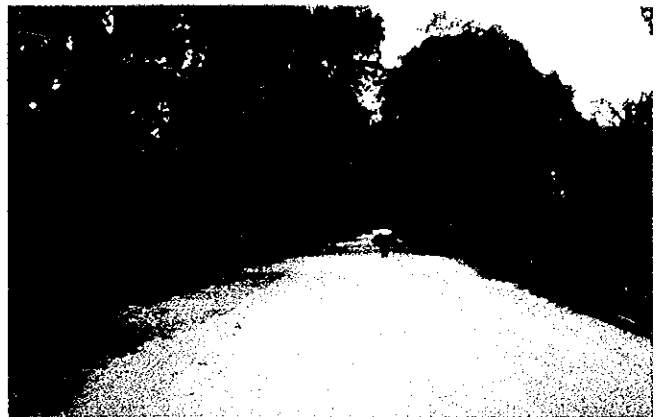
KM301+400 (地方部バライ区間)
