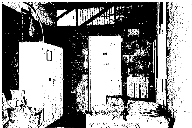
(写真-6) 分電盤室
