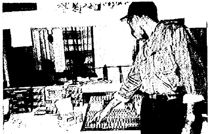
(写真-16) コントロールルーム
