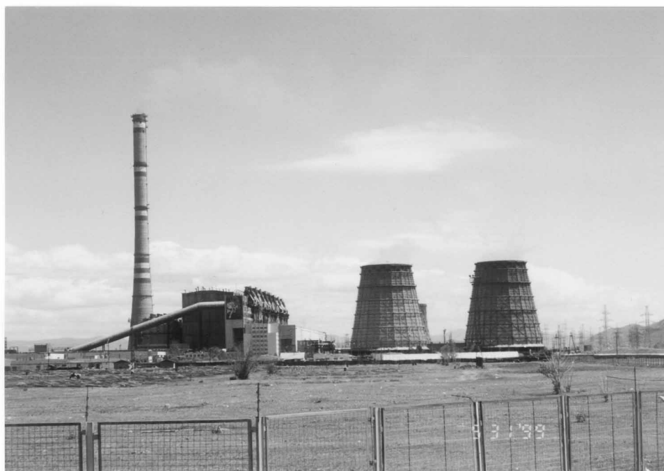
ウランバートル第4火力発電所
