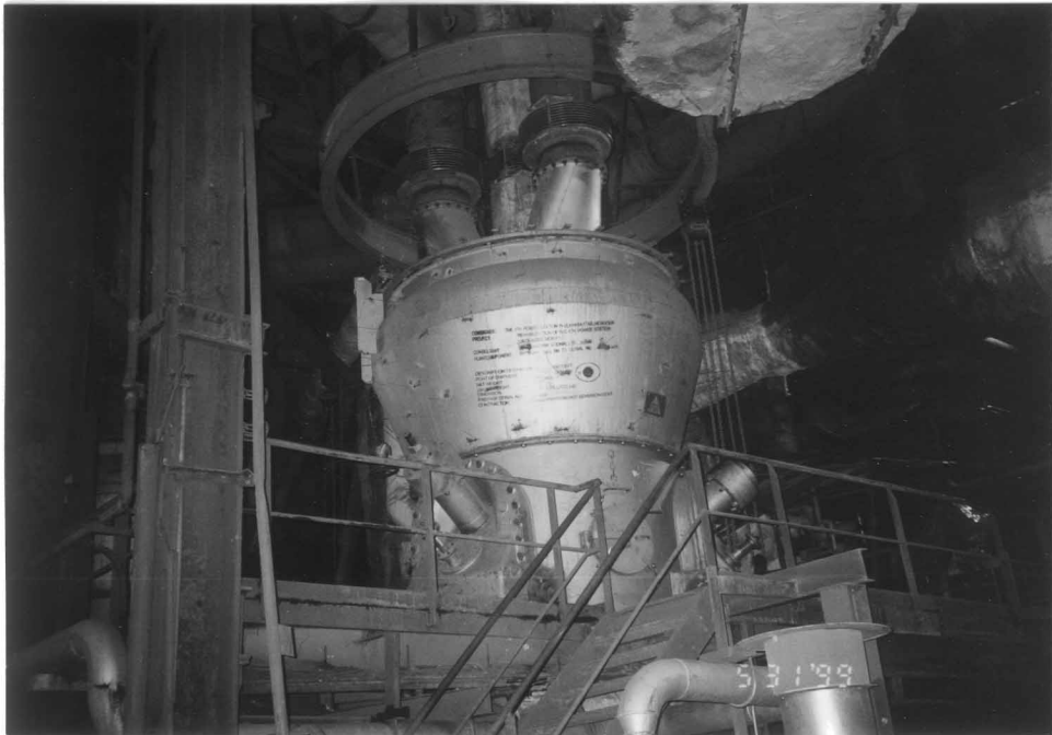
縦型ミル (新設)
