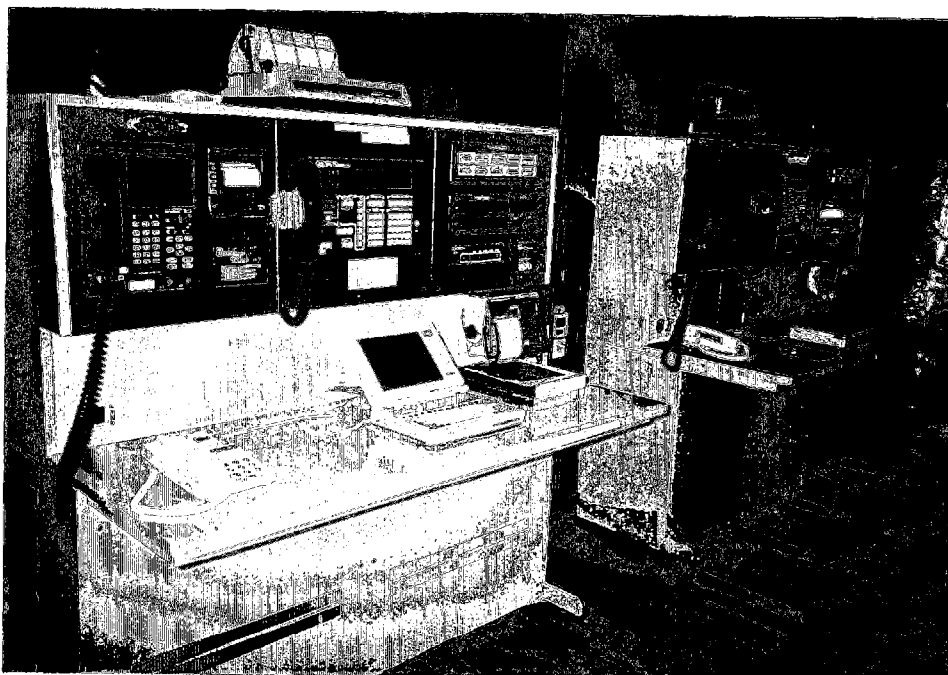
▲ パナマ航海学校(ENP)内のGMDSSシミュレーター
