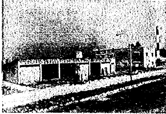
写真1 トリブバン国際空港電気棟（左）とレーダー管理棟（右）
