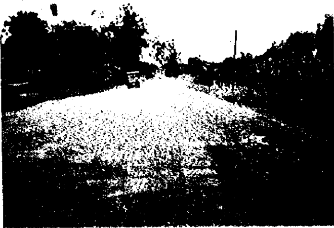
グアヤキル北部 El Empalame - Pichincha 間 2 級道路 アスファルトが殆ど摩耗して土道以下の状況となっている。バスは 状況の良い所を選び、蛇行しながら徐行を余儀なくされている。
