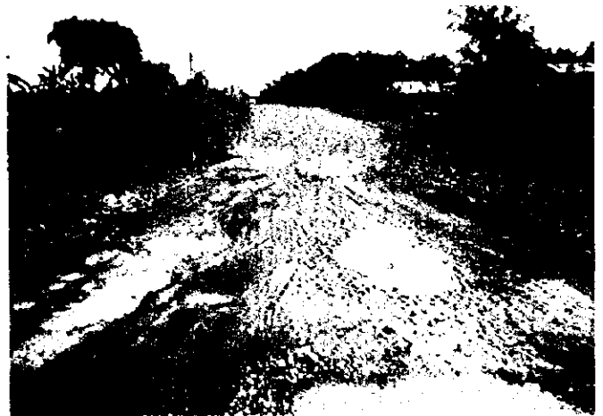
グアヤキル東方 Milagro 近辺の 2 級道路 舗装が剥離して窪みが多数できている。
