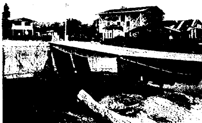
Santa Elena 近辺仮設橋（1 級道路）
