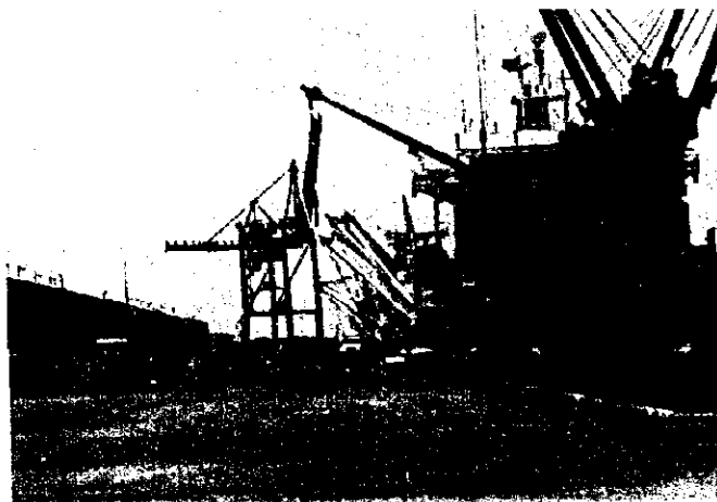
グアヤキル港湾施設 (クレーン: 40ton)
