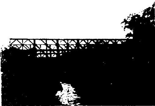
上流側から見たキングフセイン橋
