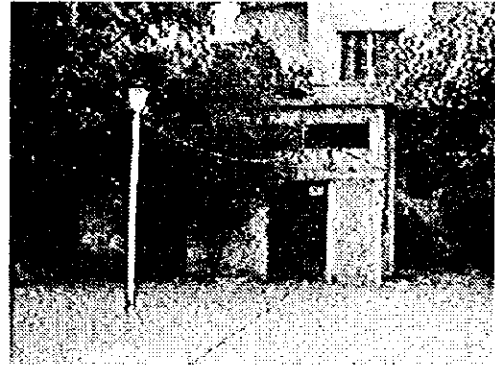
写真10-2 地上設置変圧器
