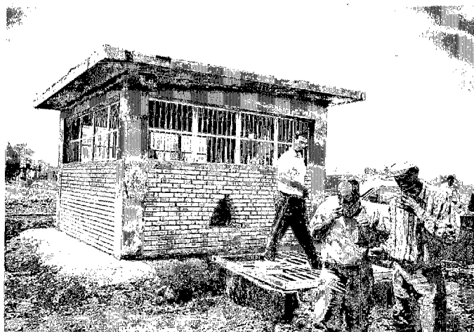
カハワギ地区 デリバリチャナルからメスカへの揚水機場(建設中) 受益面積は440FD 建設経費は農家負担
