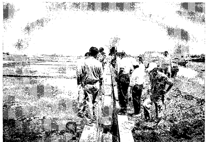
カナダ国際開発庁(CIDA)の指導によるブロックタイプの用水路(カ ワギ地区内)
