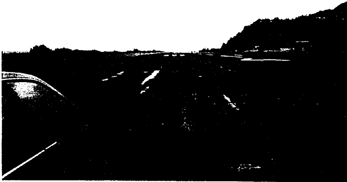
チューク国際空港滑走路 貝殻片・珊瑚片が露出しており、 発着時の事故の防止には早急な改 修が必要である。 前田・中川両土木施工隊員が計画 に取り組んでいるもののアスファ ルトプラント容量或は運行条件等 の問題が山積している。
