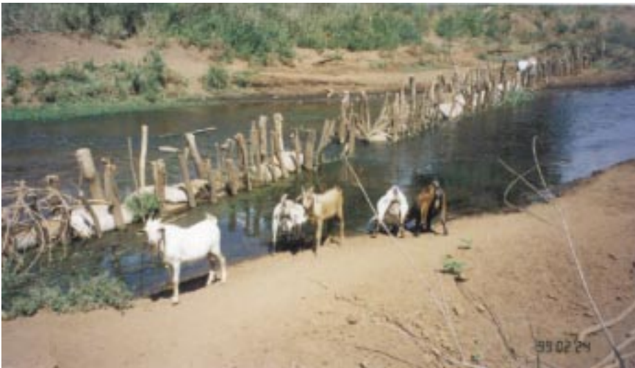
Sundai Location の Self Help Irrigation Scheme。 河川に杭や土嚢を置いた簡易なセキ。
