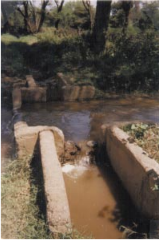
Kiserian Self Help Irrigation Scheme の河川からの取水口。 農家自ら手で水路を開削し、共同管理により灌漑事業を行っている。 (1998年9月撮影)
