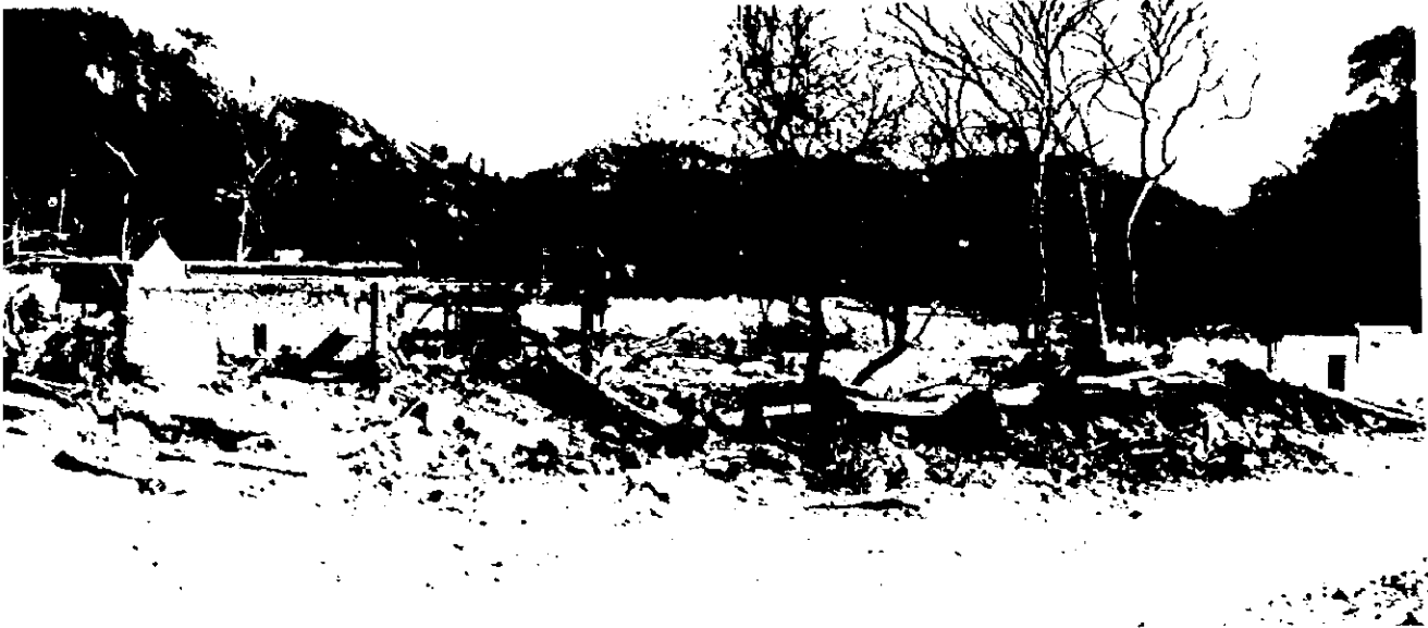
Nueva Francia del río Cintalapa. Un aspecto de siniestro azotado que dejó un poblado completamente destruido por cantos, arenas, lodos y árboles.
