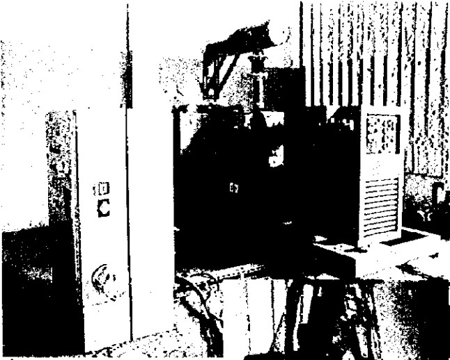
↑ La station de pompage existante dans la zone de la Cité Agricole (panneau de contrôle et générateur)
