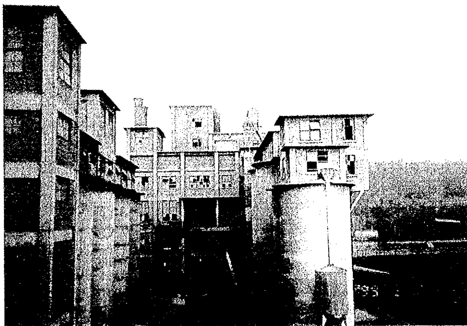
(写真 - 43) 工場全景
