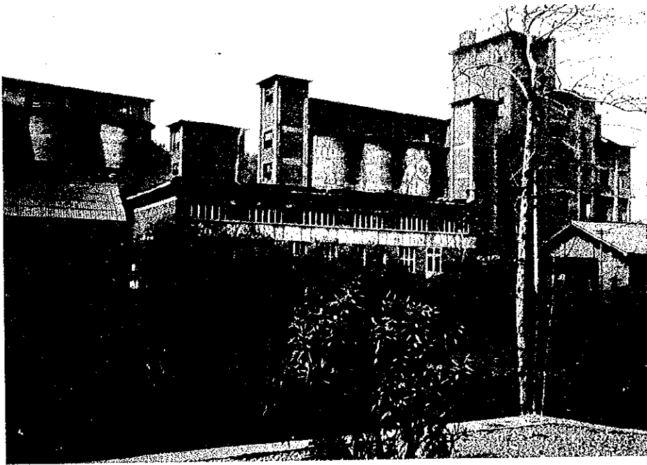
(写真 - 59) 工場全景
