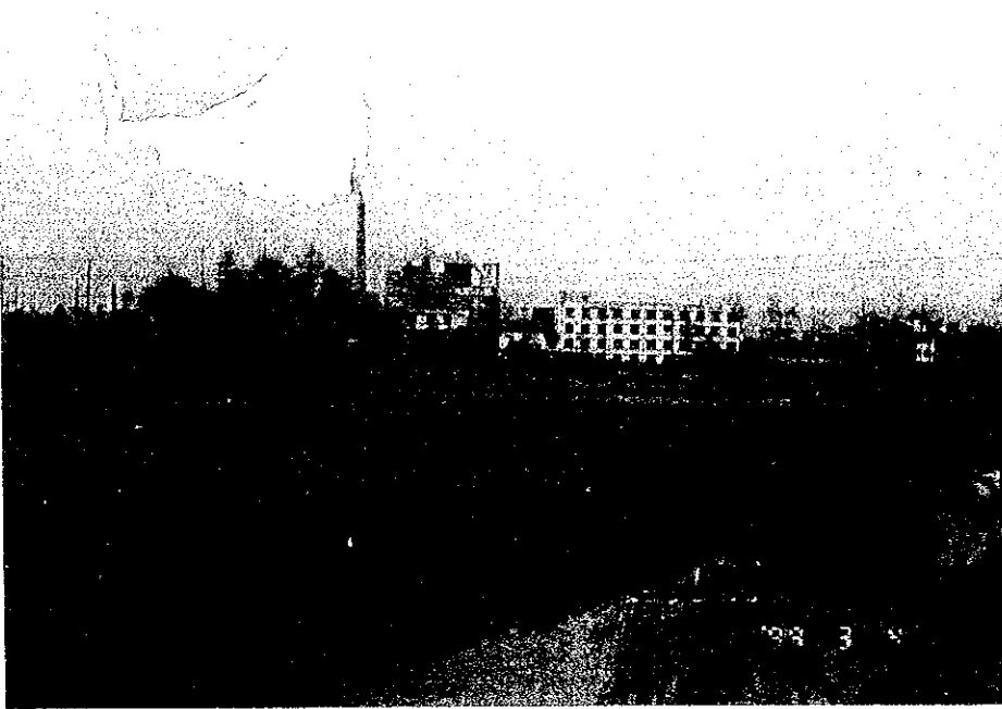
(写真 - 75) 工場全景
