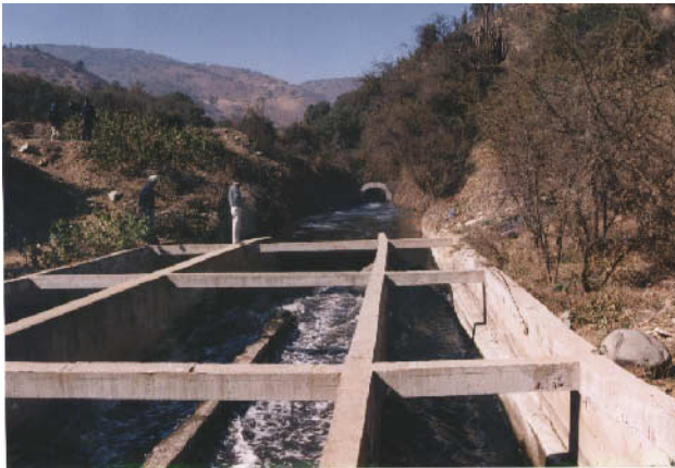
Derivadora después de la salida del túnel del Canal Mallarauco
