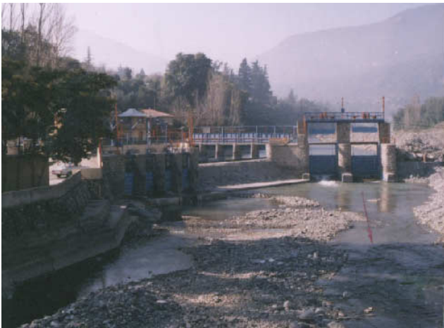
Obras de bocatoma en la primera sección del Río Maipo
