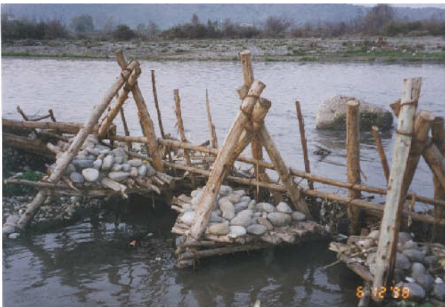
Obra de bocatoma tradicional (aguas abajo del Río Mapocho)
