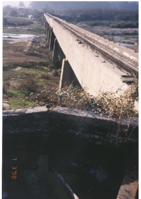
Acueducto transversal del río
