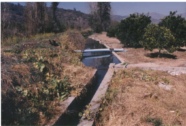
Canal secundario y derivadora
