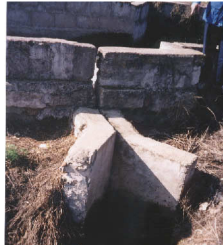
Obra de derivación tradicional, el ancho de la hendidura es determinado por el número de acciones
