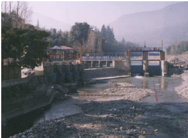
Maipo川第一セクション取水施設 (Obla頭首工) 左が農業用San Carlos水路、右がEMOSの水道用取水路
