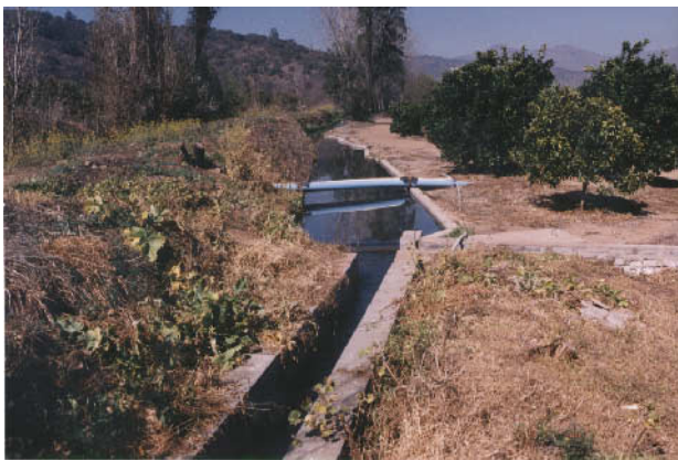
2次水路と分水工
