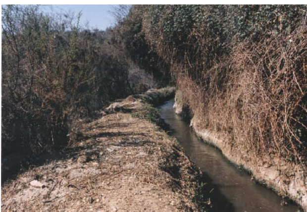
Mallarauco-Las Carrera地区南幹線水路
