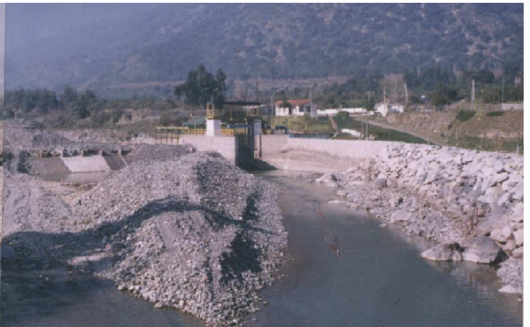
Maipo川第一セクション取水施設 (Obla頭首工) 左が農業用San Carlos水路、右がEMOSの水道用取水路
