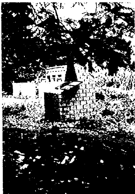
汲知所(アラダ地区病院)
