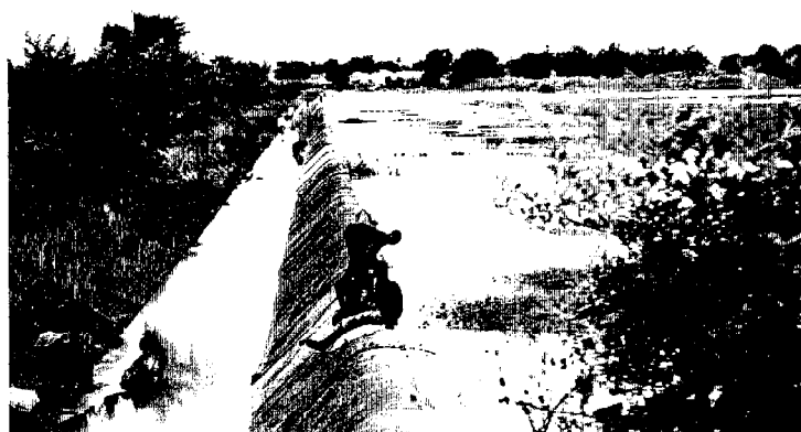
2-2 モグテド地区灌漑用ダム
