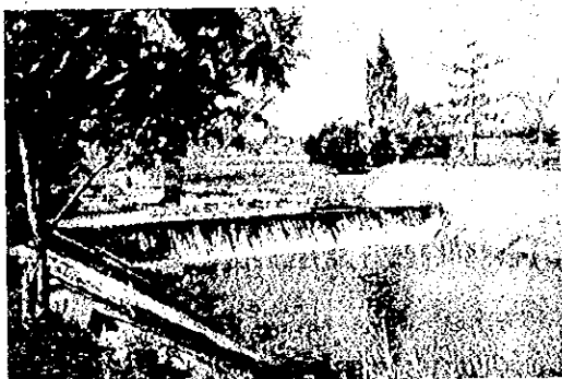
Huai Som Weir
