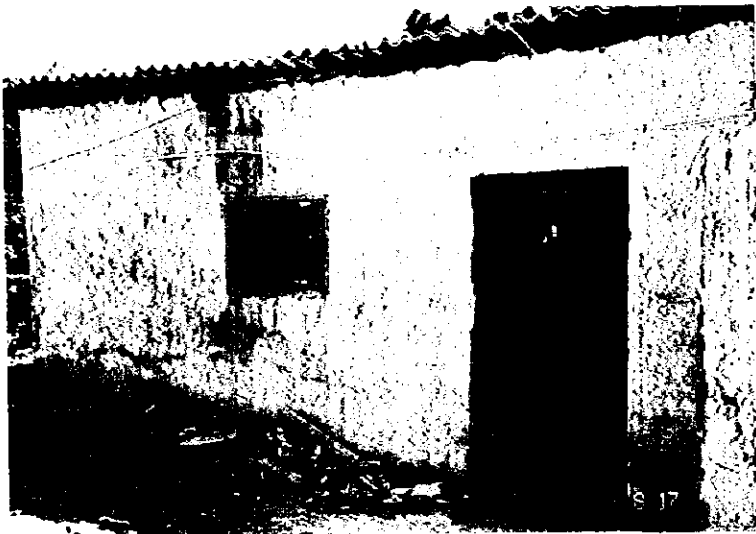
写真9 コールドチェーン機材はアパートの 屋上の仮設小屋に収納されている
