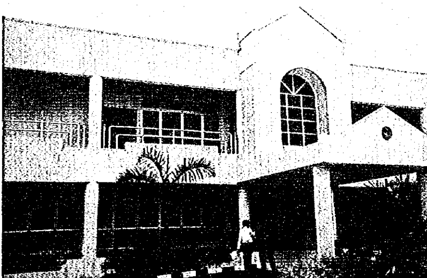
3. CIAST内 R&Dセンター 日本・マレーシア技術学院 (JMTI) 用の仮施設として 使用予定
