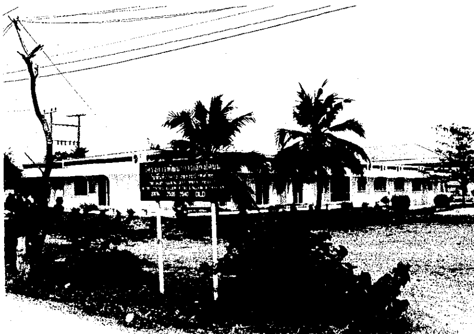
▲パトムタニA | センター事務・管理棟
